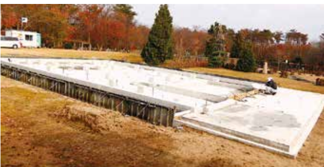
基礎工事の様子
